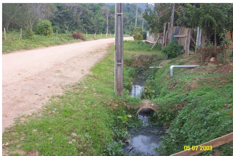
Vala negra na rua Manoel Calixto Rodrigues.
