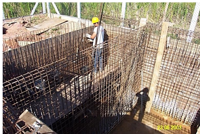
Foto 16 – Trabalhador preparando a ferragem de caixa de drenagem, antes da concretagem. (AFANP)
