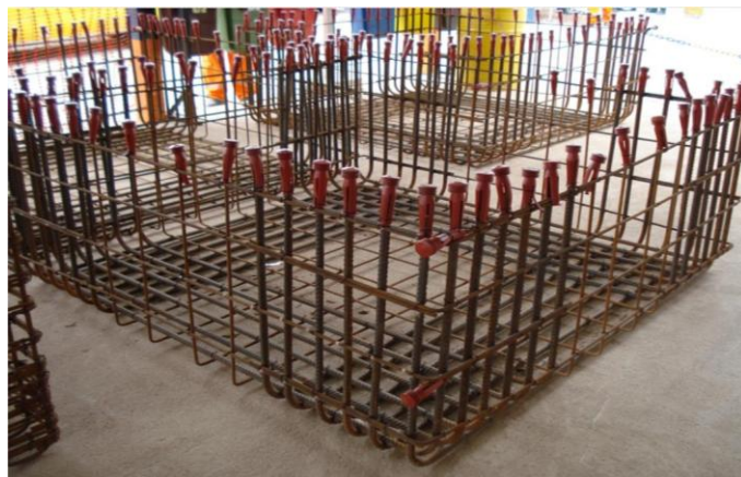
Foto 6 – Na central de armação as pequenas lesões, por arranhões em contrato com arames e extremidades de vergalhões eram de 2 ocorrências relatadas por semana passando a uma ocorrência relatada a cada quadrimestre. Todas as extremidades de barras e vergalhões passaram a ser protegidas até o posicionamento final para a concretagem nas formas de concreto. (AFANP)
