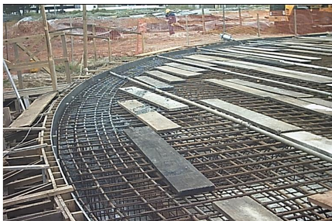
Foto 15 – Assentamento de tábuas sobre as ferragens da laje de concreto para facilitar o deslocamento dos trabalhadores que irão concretar laje onde ficará apoiado Tanque. (AFANP)
