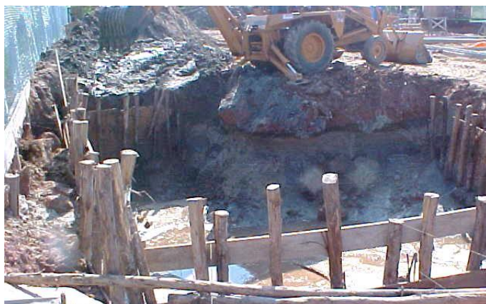
Foto 15 – Escavadeira aprofundando vala com a sapata do equipamento sem qualquer apoio e com risco de queda. (AFANP)
