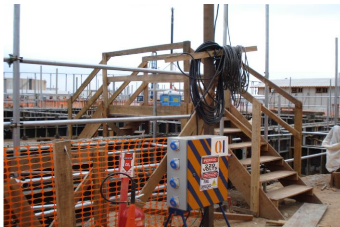
Foto 8 – Uma das travessias que mais gerava desvio e quase acidentes era a da transposição de linhas de dutos. Os trabalhadores construíram escadas de transposição e passarelas, além da instalação de painéis elétricos identificados e protegidos. (AFANP)
