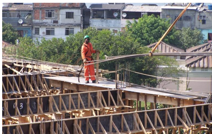
Foto 20 - Trabalhador segurando com as mãos feixe de varas de aço para a montagem das ferragens nas fôrmas, com risco de ser perfurado por essas durante a movimentação do guindaste. (AFANP)
