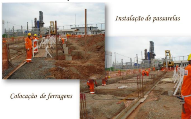
Foto 7 – Locais onde eram realizadas escavações para o posicionamento de ferragens de armações de concreto armado, protegidos e identificados. Praticamente todas as sugestões adotadas foram sugeridas pelos trabalhadores. (AFANP)
