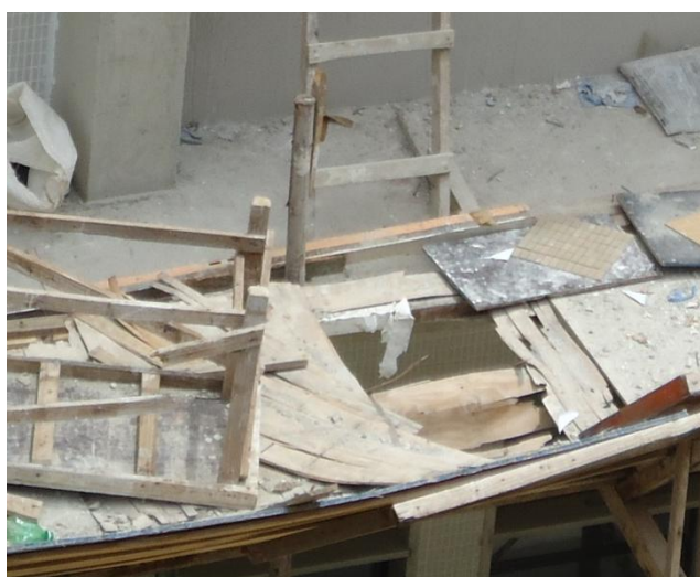
Foto 19 - No detalhe, local onde as extremidades de escada improvisada se encontra apoiada, na borda de platibanda de edificação em construção. (AFANP)
