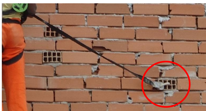
Foto 2 – Ampliação do ponto de “atracação” do talabarte do cinto de segurança. (AFANP)
