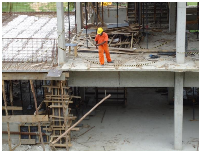
Foto 12 – Operário removendo as escoras de apoio das fôrmas das lajes de concreto, arremessando-as para baixo, a fim de que outro operário as retire. (AFANP)
