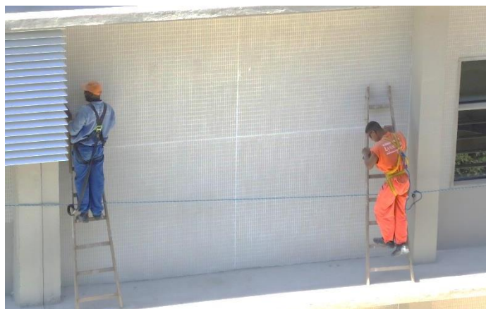
Foto 16 - Trabalhadores rejuntando pastilhas de revestimento de fachada, sobre escadas de madeira inapropriadas, em platibanda de edificação, presos pelos talabartes dos cintos de segurança à mesma linha de vida. A queda de um arrastará o outro trabalhador. (AFANP)
