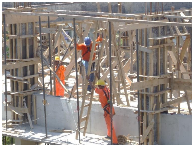
Foto 21 - Trabalhador segurando escada de madeira sobre platibanda de prédio em construção para que carpinteiro conclua a forma de concreto. (AFANP)
