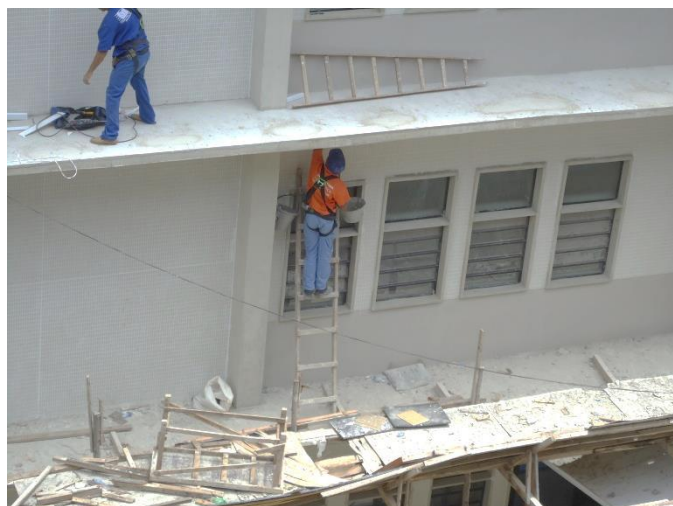
Foto 18 - Trabalhador apoiado em escada improvisada com elevado risco de queda. (AFANP)
